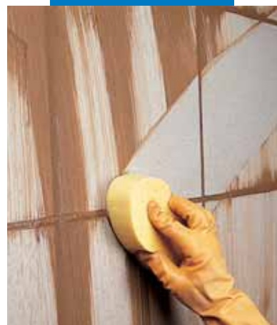
Φινίρισμα τοίχου με σφουγγάρι
