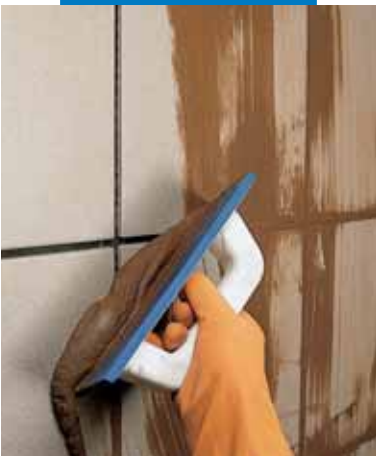
Αρμολόγηση εξωτερικού τοίχου με σπάτουλα
