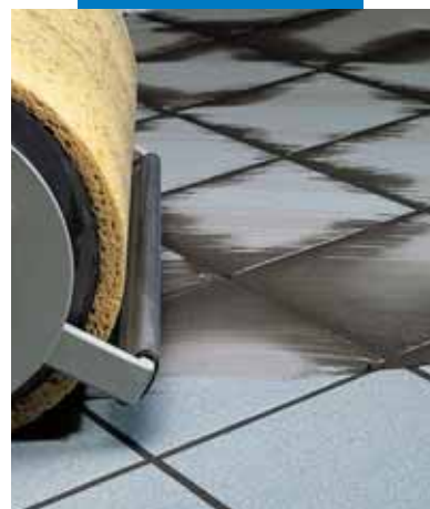
Φινίρισμα δαπέδου με μηχανικό λειαντήρα
