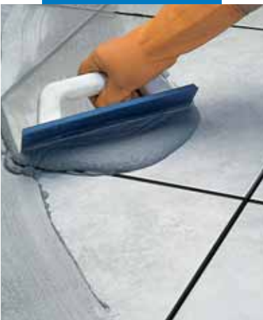
Αρμολόγηση κεραμικού πλακιδίου δαπέδου με σπάτουλα
